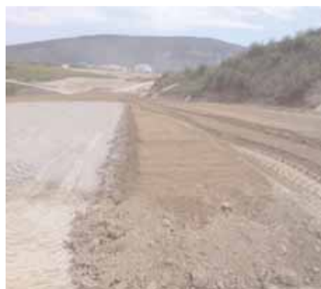
Stabilisierung mit Kalk und Zement
