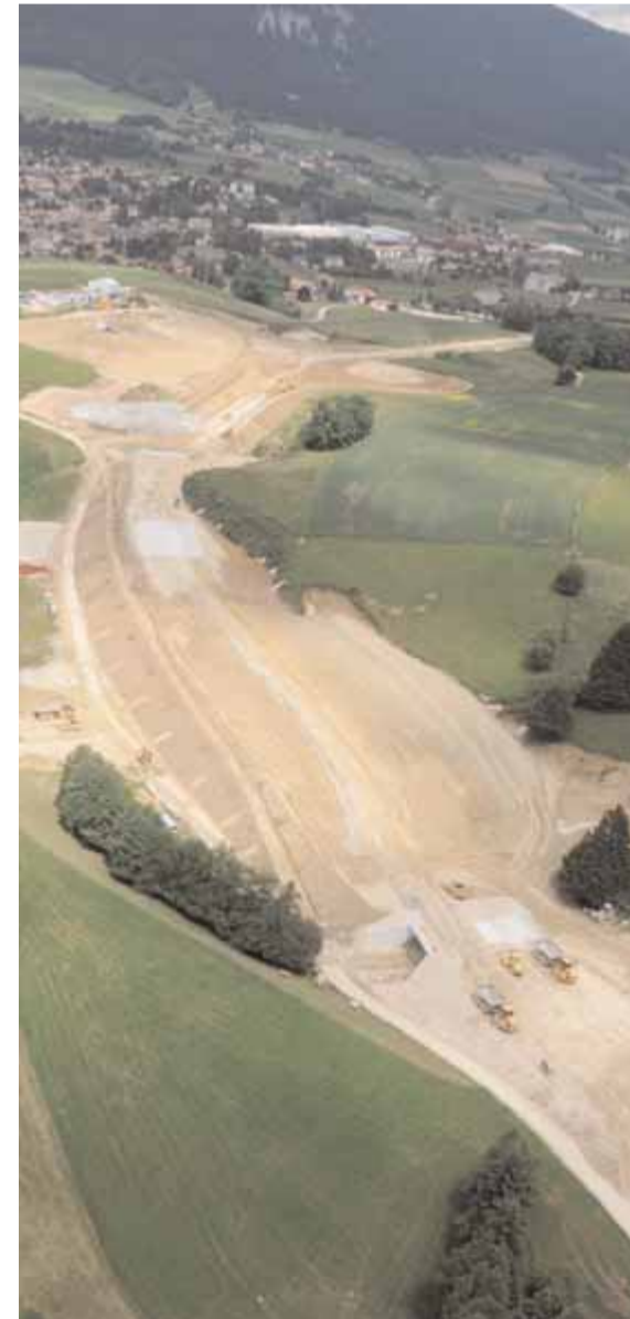
Baustelle im Raum Reconvilier (Juni 2008)
