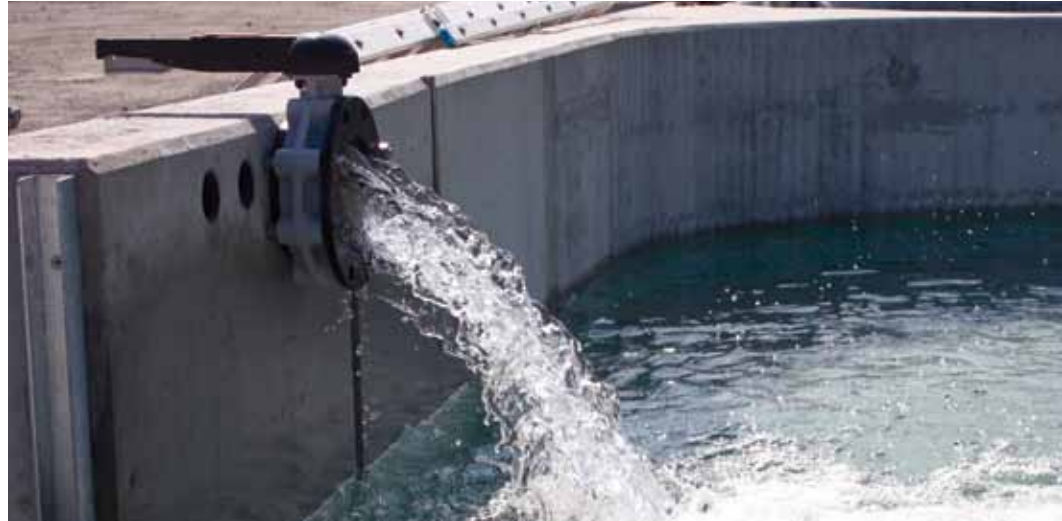
Erste Flutung der Fischzuchtbecken
