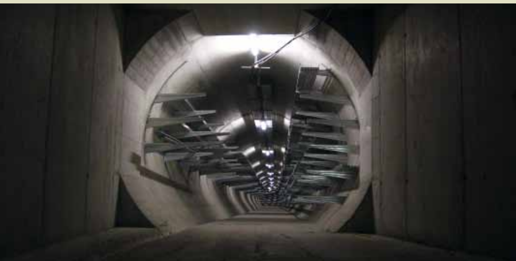
Werkleitungsstollen Reussport im Rohbau
