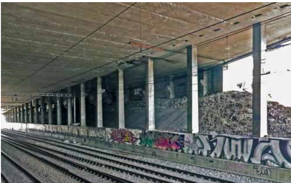
Untersicht der bestehenden 3-feldrigen Brückenkonstruktion
