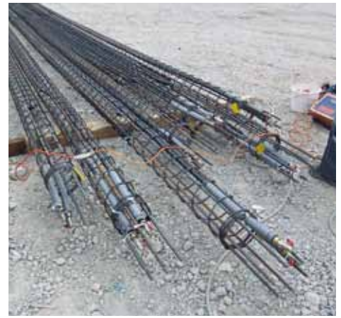
Pfahlbewehrung mit eingebauten Energieleitungen
