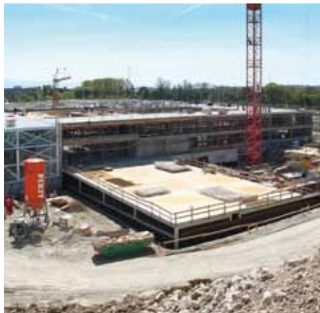
Die Baustelle des Verwaltungsgebäudes Bobst Group und des Showrooms
