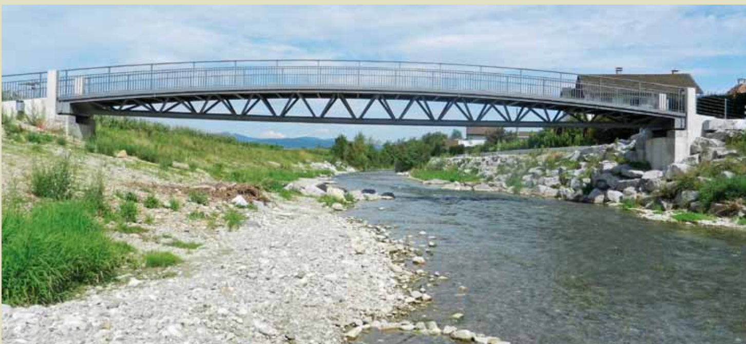
Neubau der Fussgängerbrücke «Bifang»
