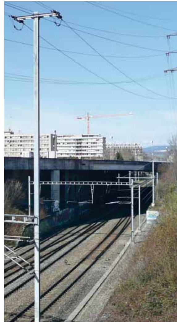
Ansicht der bestehenden Brücke T2 im Jahr 2008
