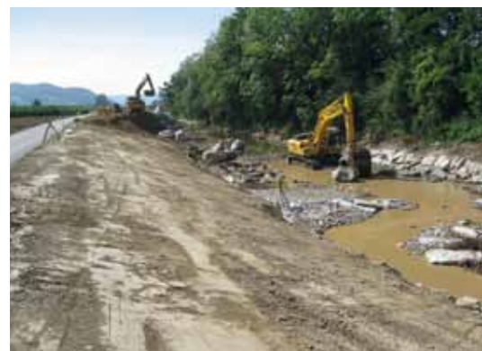
Von der Baustelle ...
