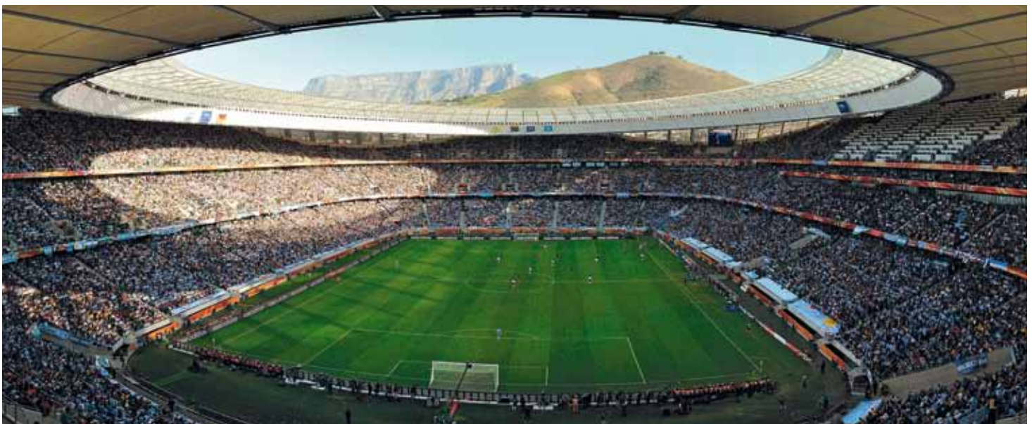
Cape Town Stadium, Südafrika: Temporäre Sitzplatzerweiterung im dritten Rang
