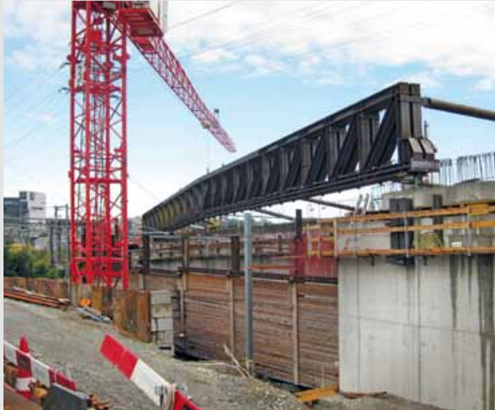
Neuer Stahlfachwerkträger, wird später vollständig mit Stahlbeton umhüllt
