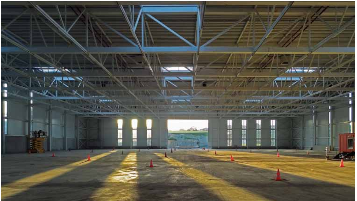
Das Stahltragwerk des Showrooms
