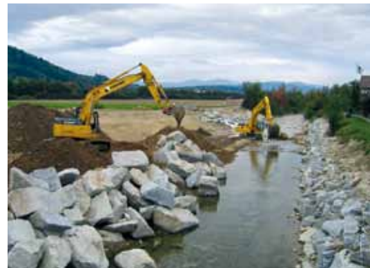
Bauarbeiten für den Hochwasserschutz
